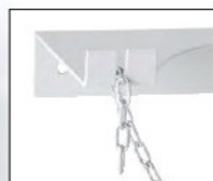
Detale łańcucha służącego do zabezpieczania butli.
